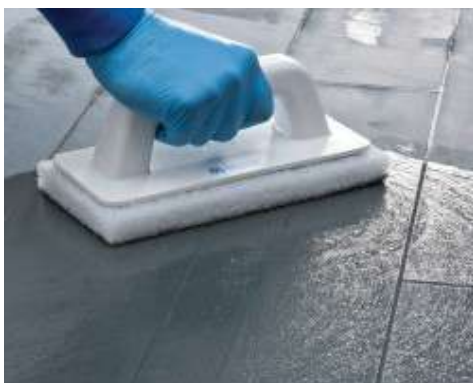
Nettoyage des joints en sol avec le PAD blanc (sur produit partiellement durci)
