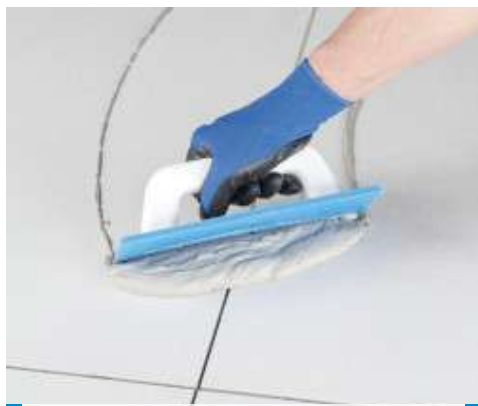
Jointoiement en mur avec la spatule caoutchouc
