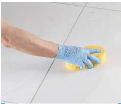
Nettoyage et finition des joints à l'éponge, en mur
