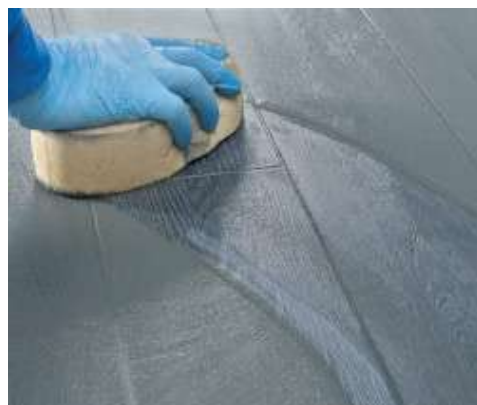
Nettoyage et finition des joints à l'éponge
